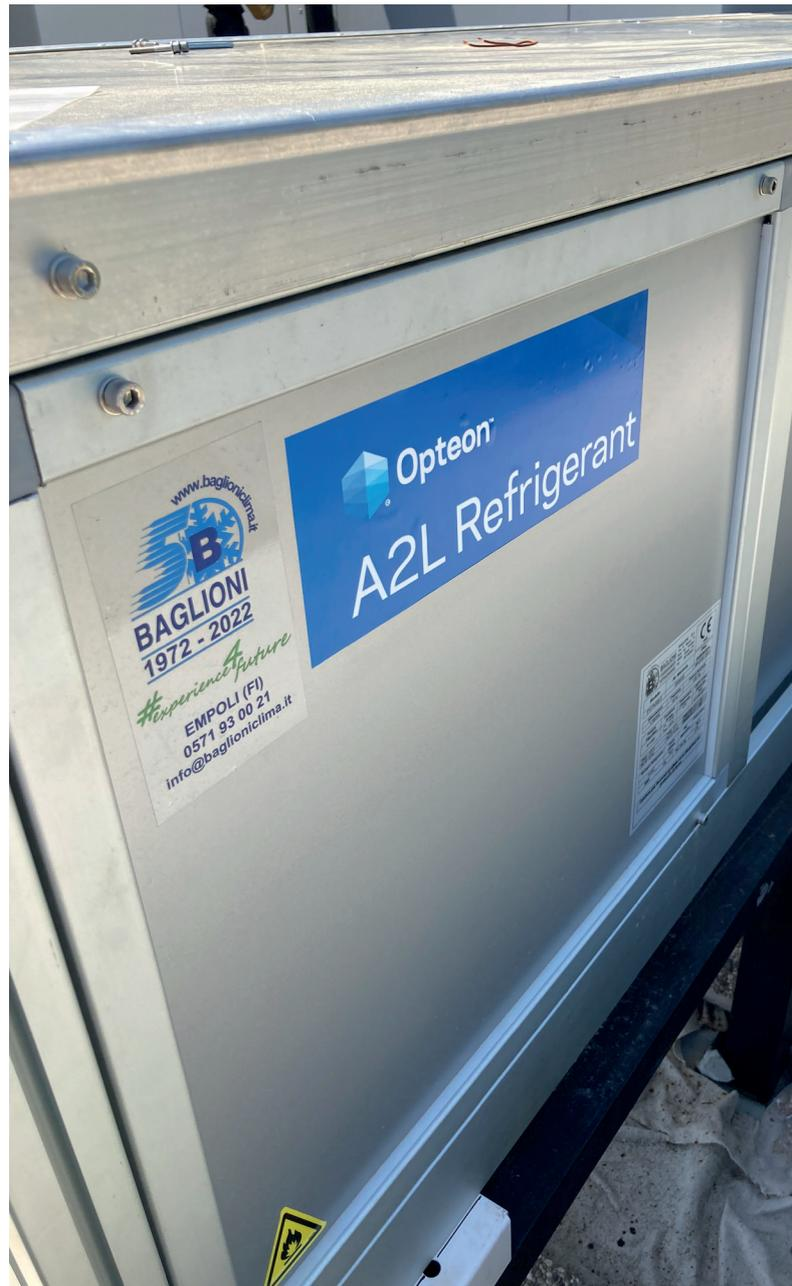
**Opteon™ XL20 (R-454C) si è dimostrato un validissimo sostituto del R-404A, adatto a garantire le alte prestazioni necessarie per il funzionamento dei processi di produzione e riducendo del 96 % le emissioni dirette in ambiente.**
